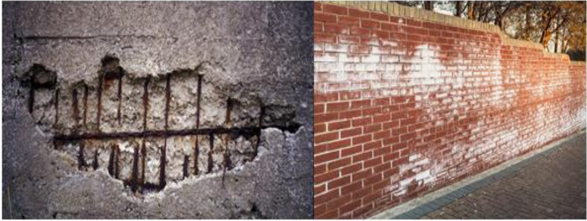
Рис. 3. Види корозії будівель: а) розшаровування бетону через корозію арматури, б) висоли на цегляній кладці
